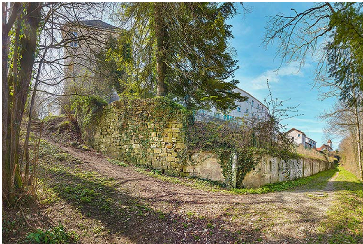
Mur d'enceinte dans le prolongement du front.
