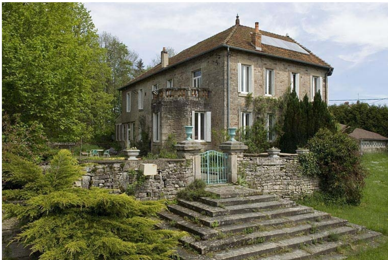
Logement patronal vu de trois quarts.
