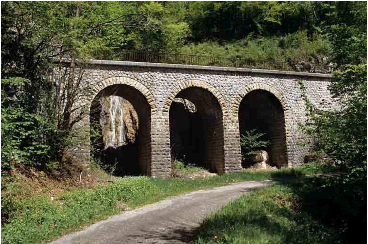
Viaduc, vu de trois quarts gauche.
