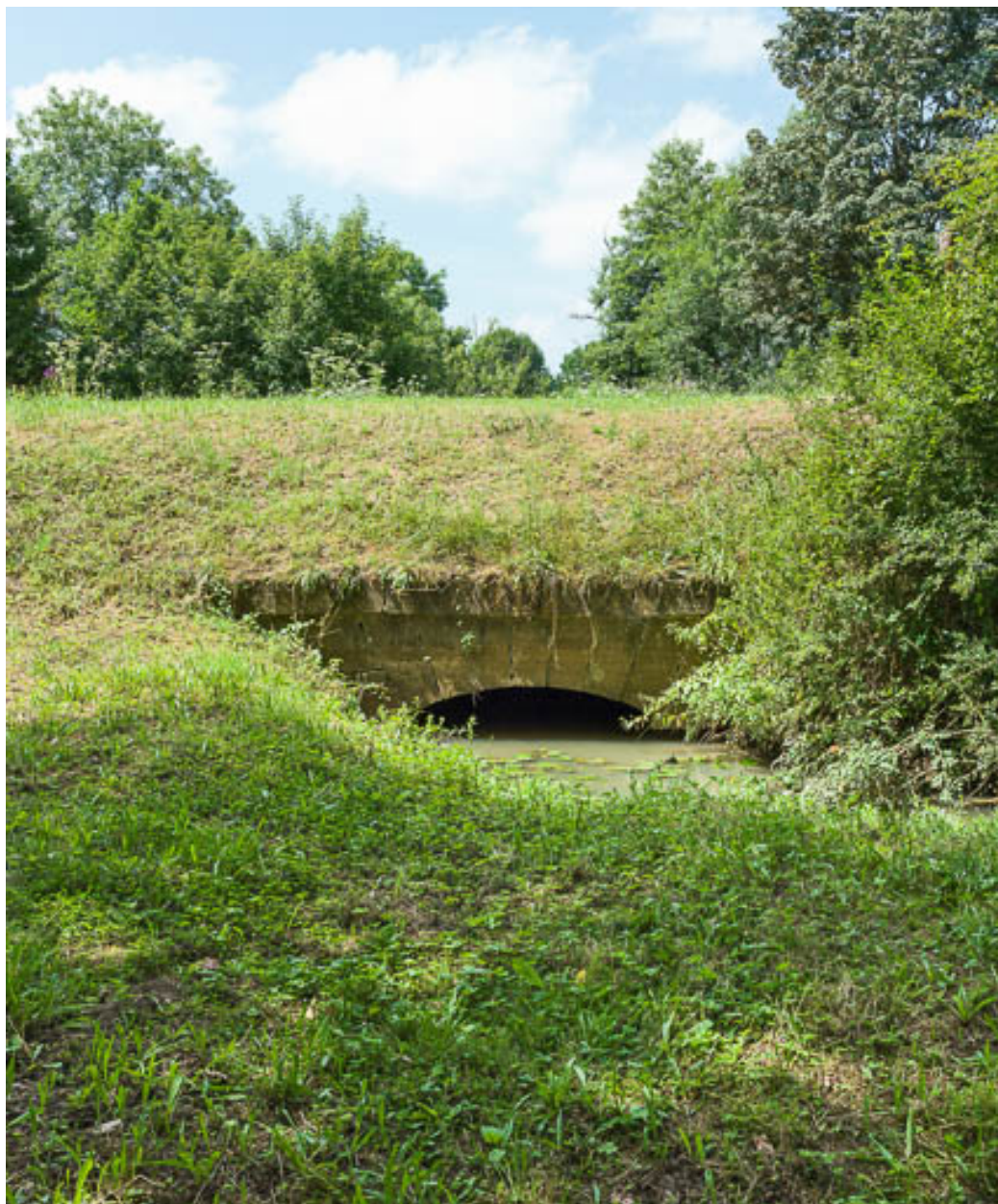
Vue de l'aqueduc.
