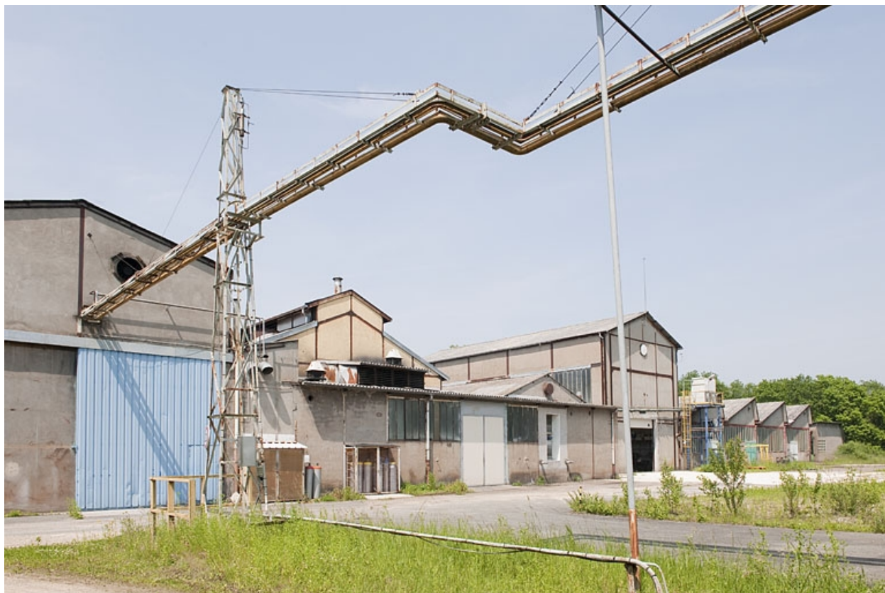
Pignons des bâtiments industriels depuis le sud.
