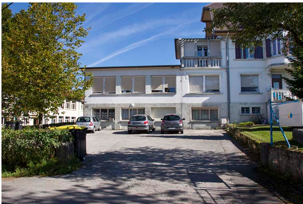
Usine : façade antérieure.
