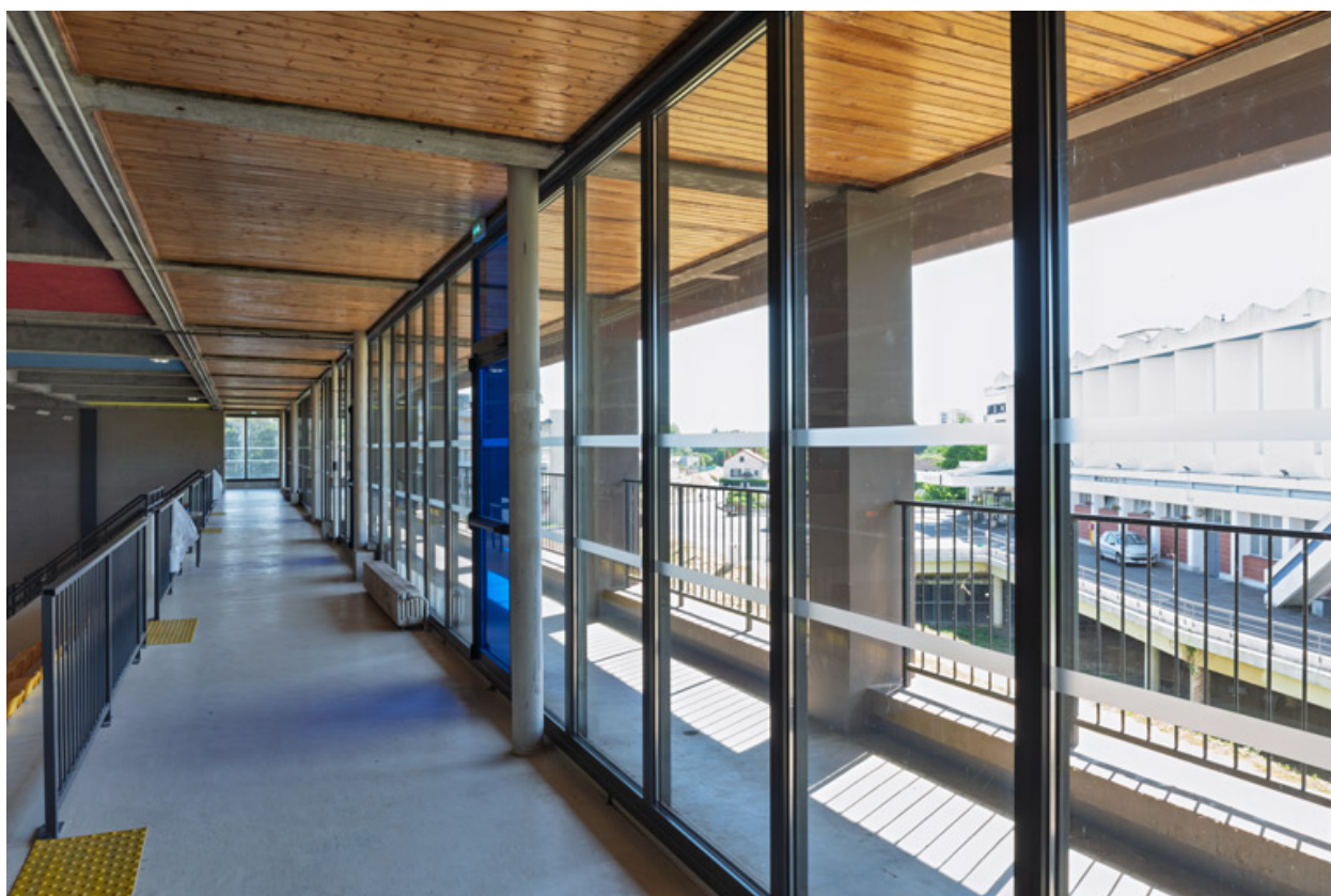
Maison des sports, grand gymnase : galerie vitrée en haut des gradins côté Loire.
