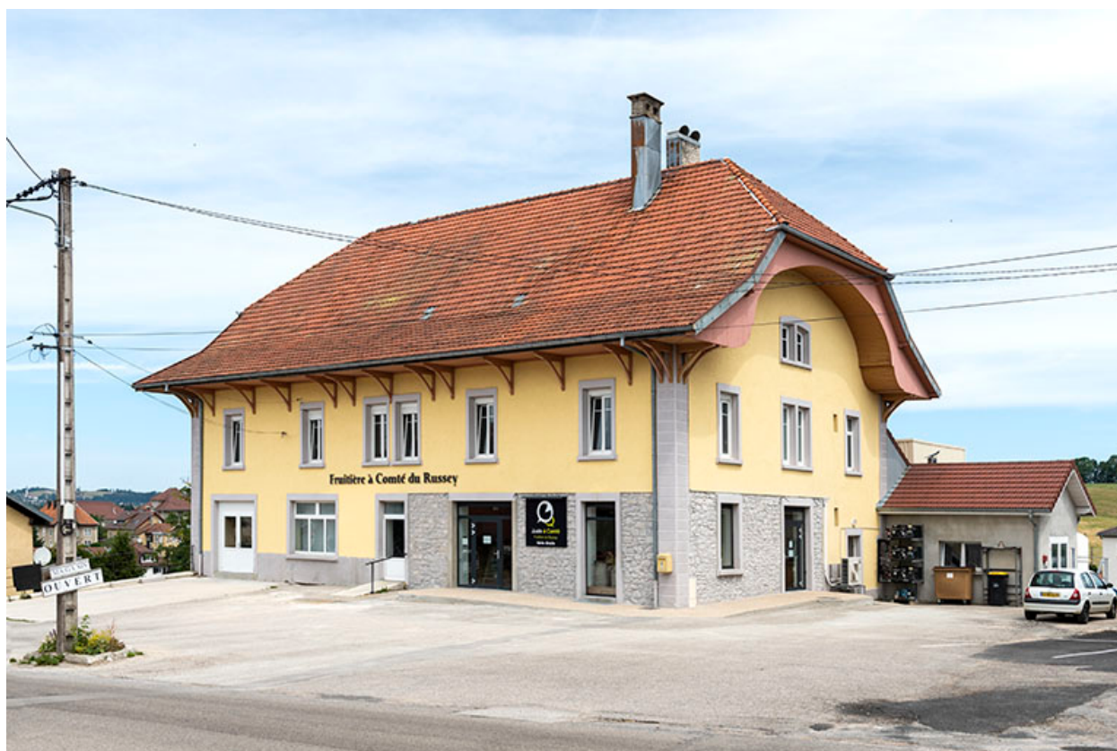
Façades antérieure et latérale droite (après rafraichissement).
