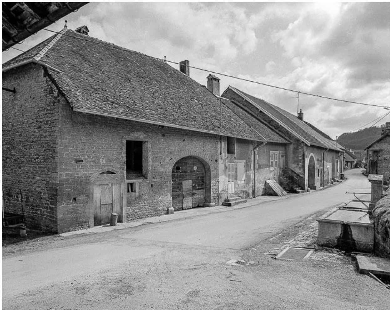
Fermes situées rue du Dessous.
