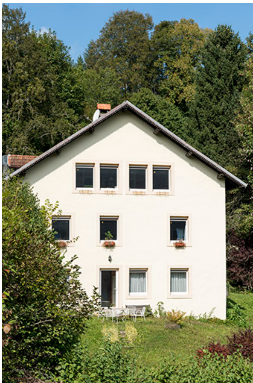
Façade latérale droite.
