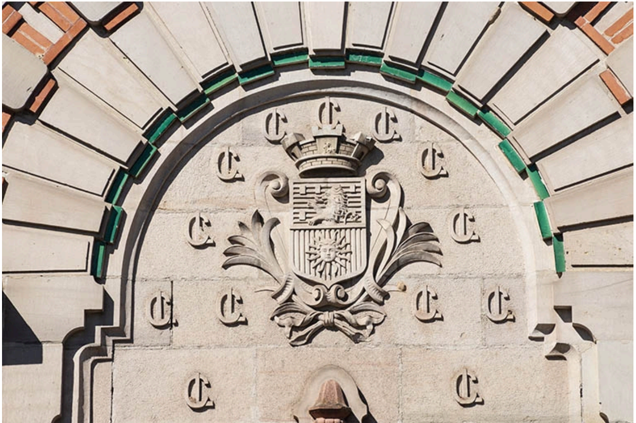
Façade sur la rue de Grammont, partie centrale, portail, détail : écu aux armes de la Ville de Luxeuil.
