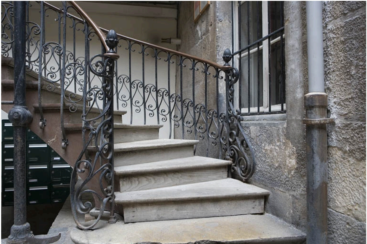
Détail du départ de l'escalier à cage ouverte, vue horizontale.
