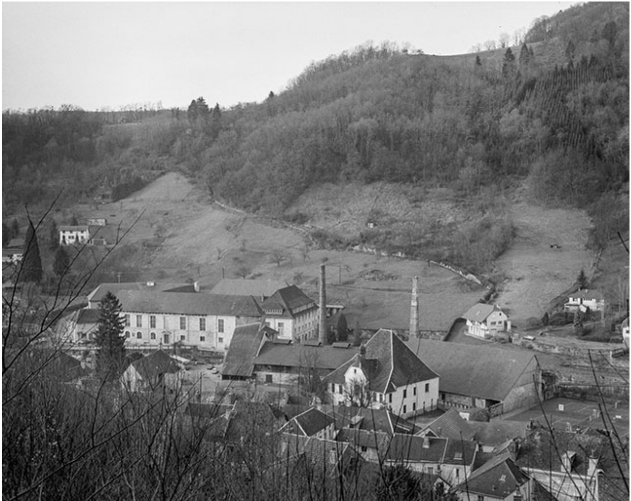
Vue d'ensemble plongeante depuis le nord-est.
