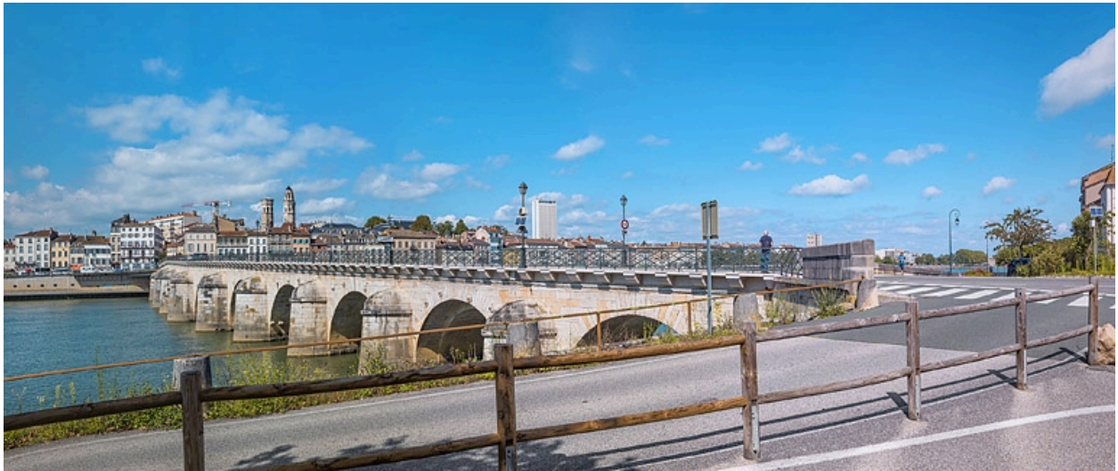
Vue d'ensemble du pont, d'aval et depuis la rive gauche.
