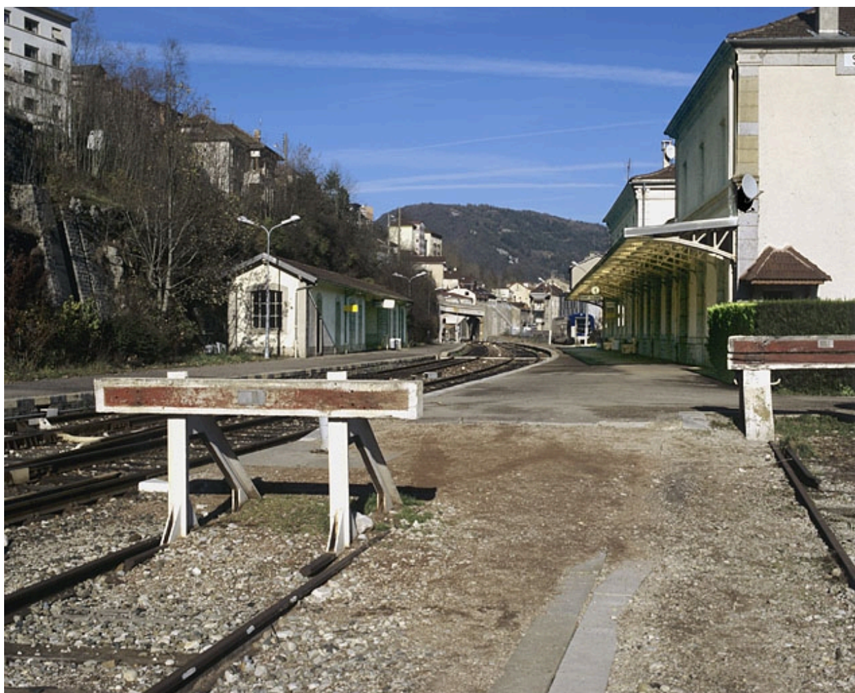
Vue d'ensemble des butoirs.
