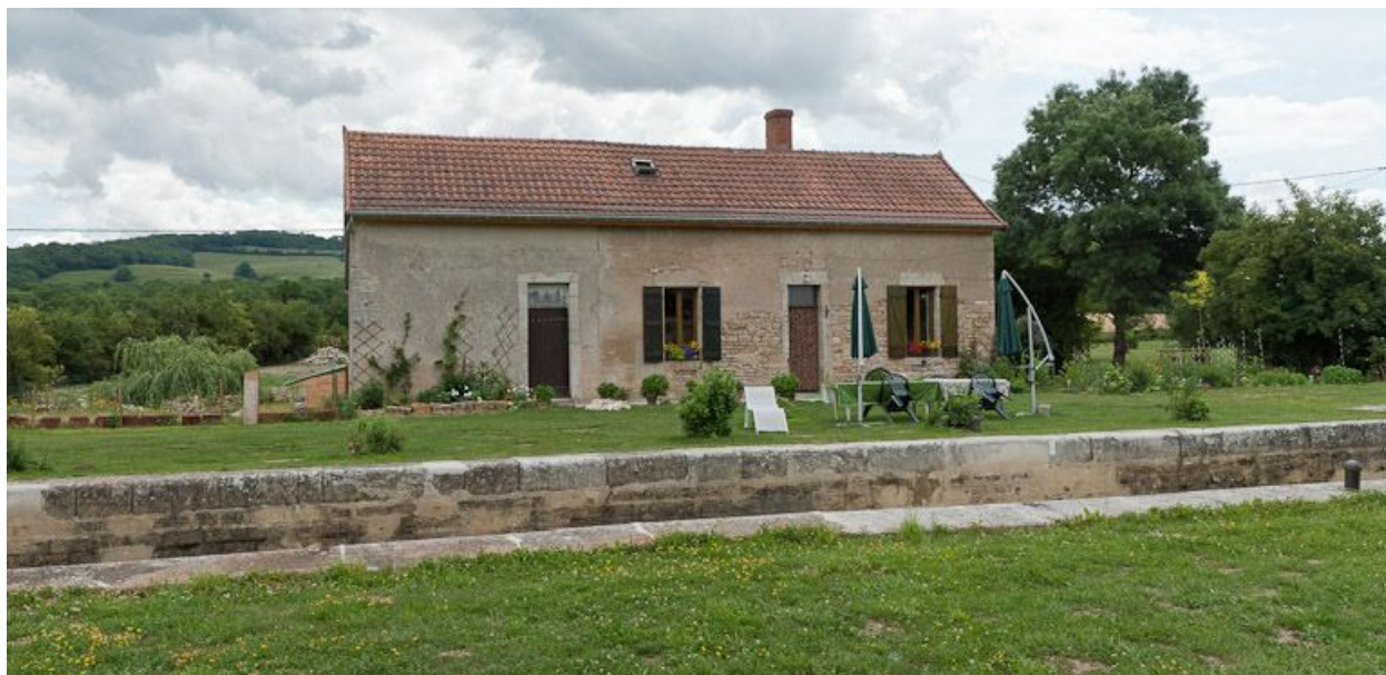
Vue de face de la maison éclusière.
