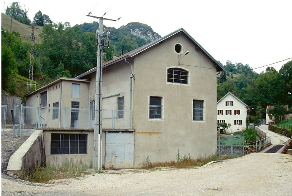
Façades antérieure et latérale droite.
