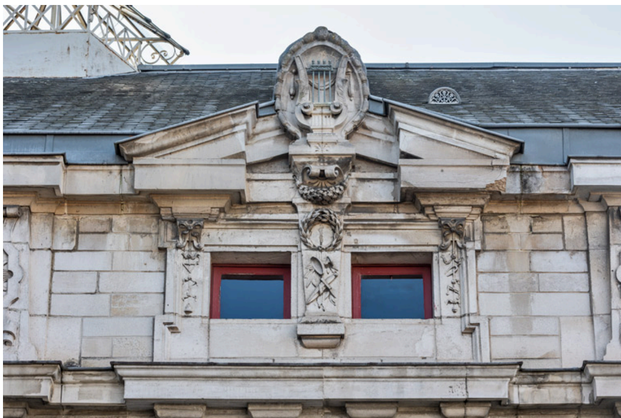
Façade latérale gauche, attique : baies et fronton formant l'amortissement de la travée centrale.
