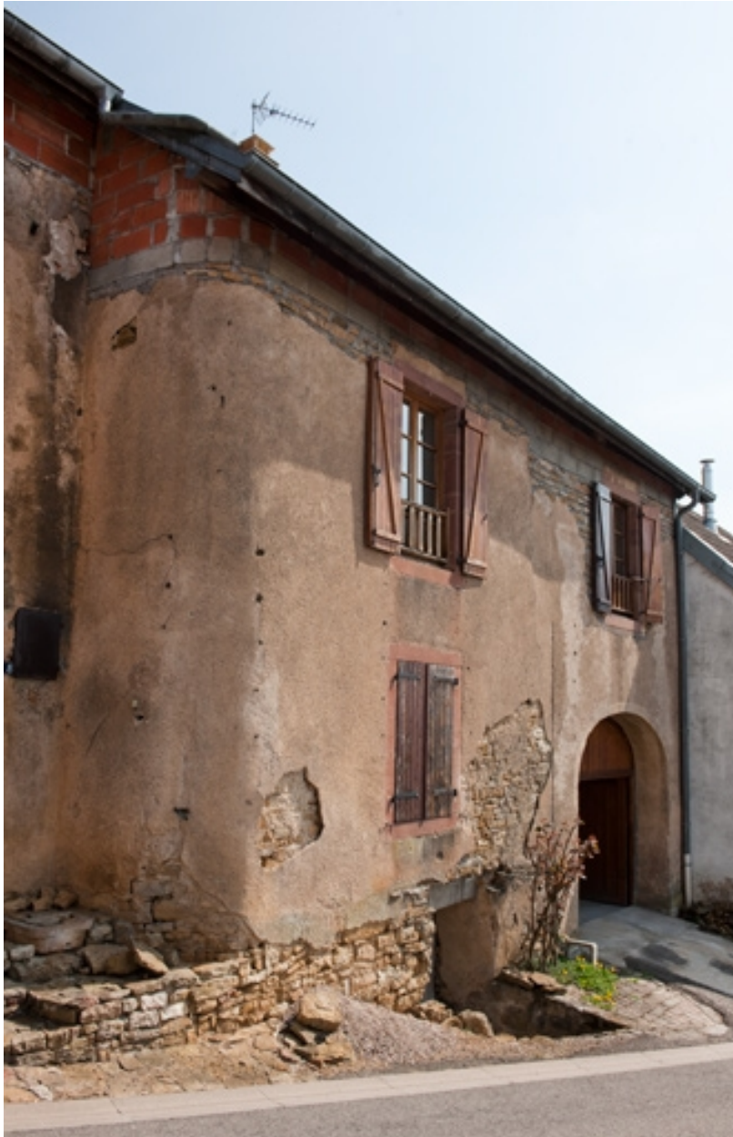
Vue rapprochée de la façade antérieure.
