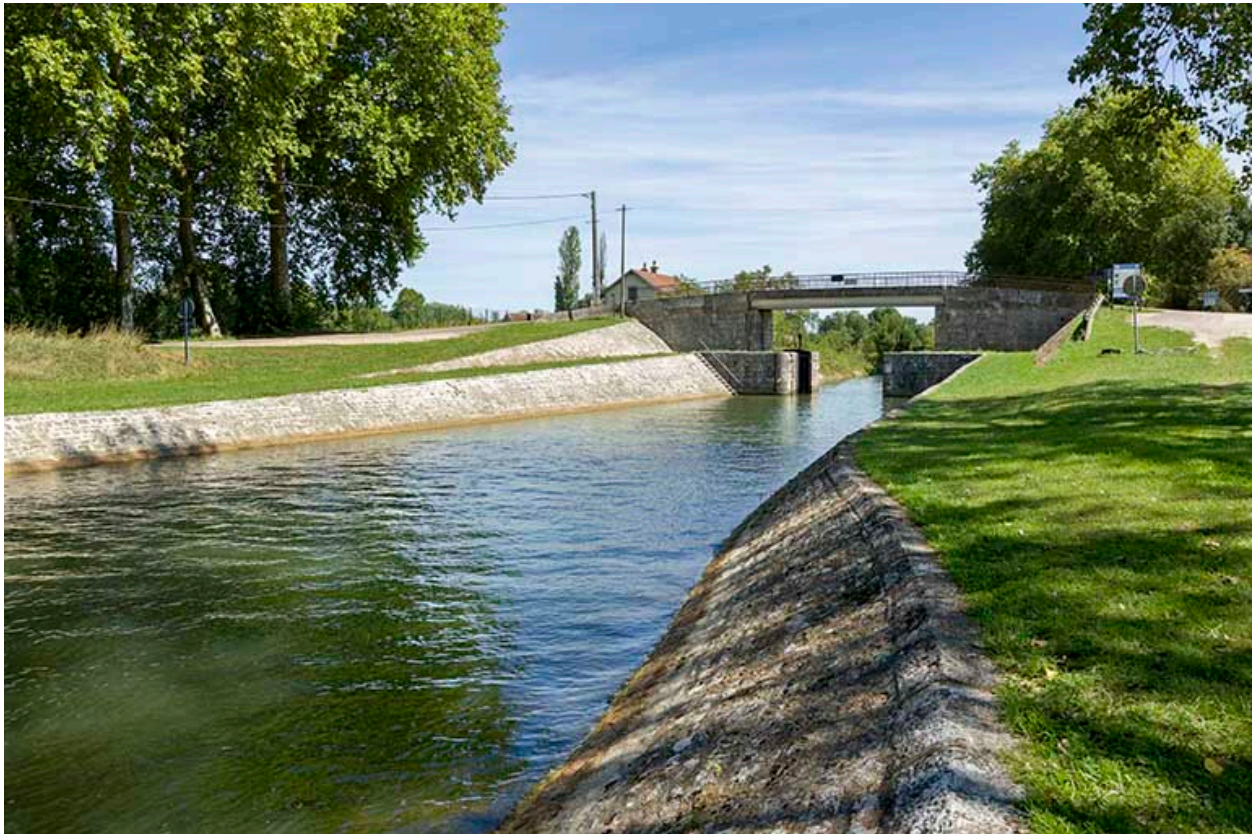
Vue depuis l'aval de la porte de garde et la maison du barragiste en arrière-plan.
