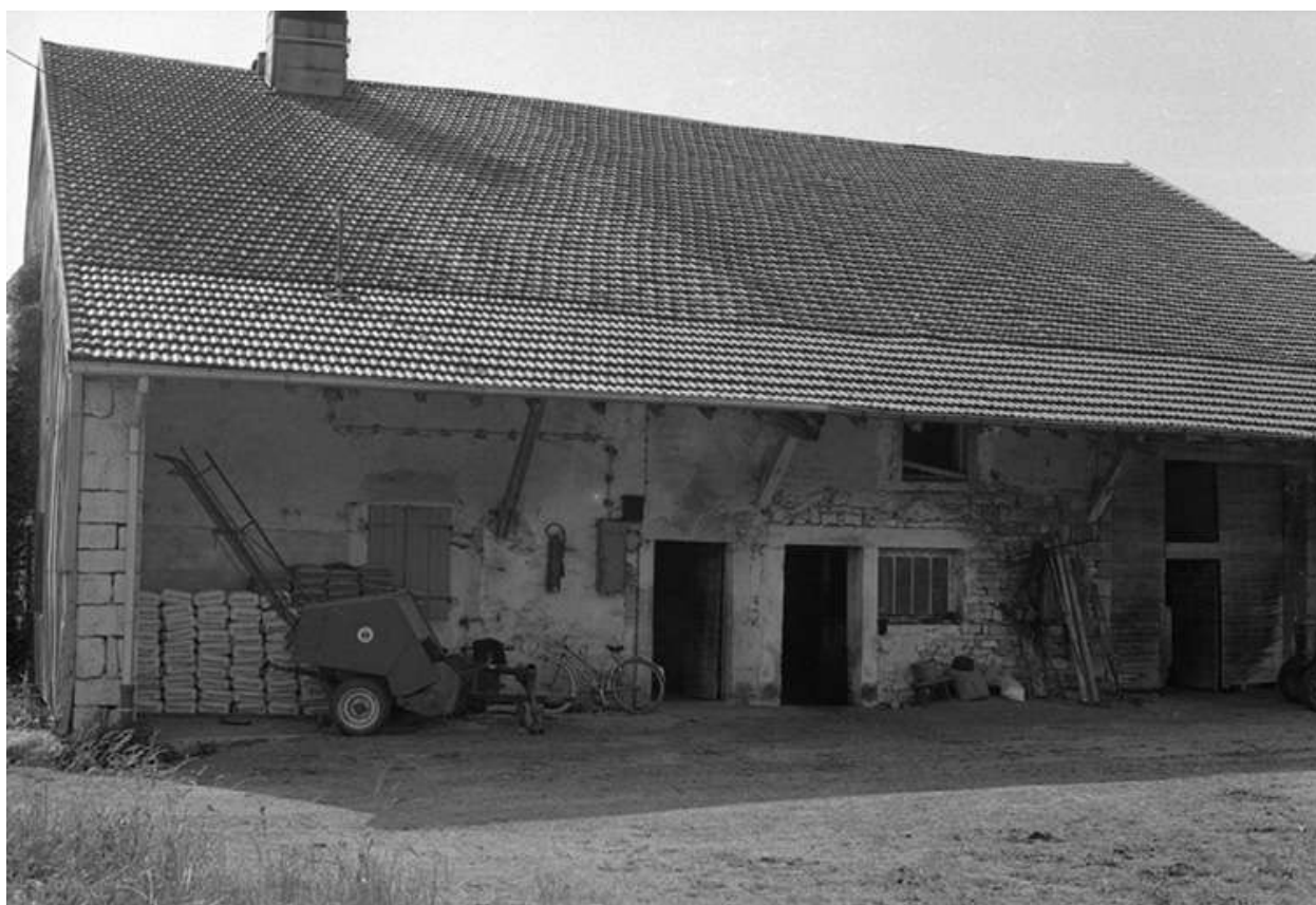
Façade latérale droite.
