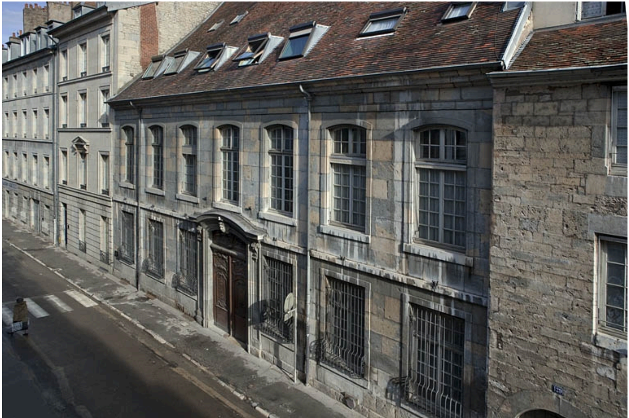
Façade antérieure sur rue, de trois quarts droit, vue éloignée.
