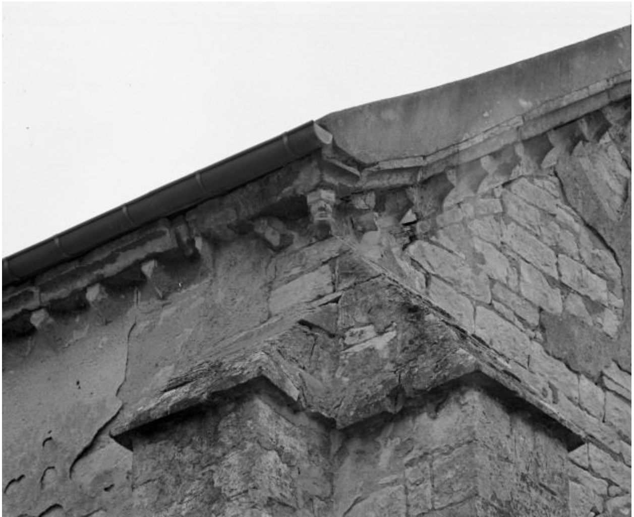
Façade : détail de l'angle gauche du pignon.
