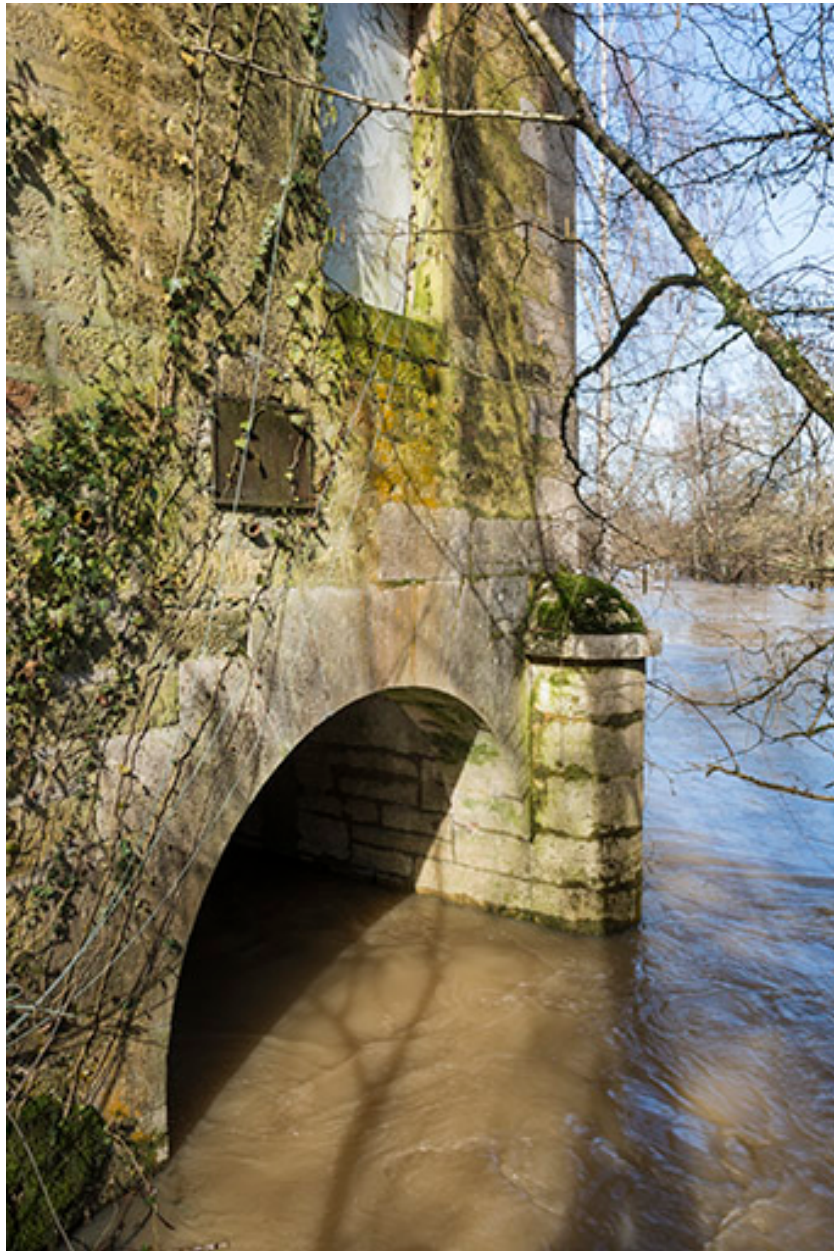
Canal de fuite du moulin.
