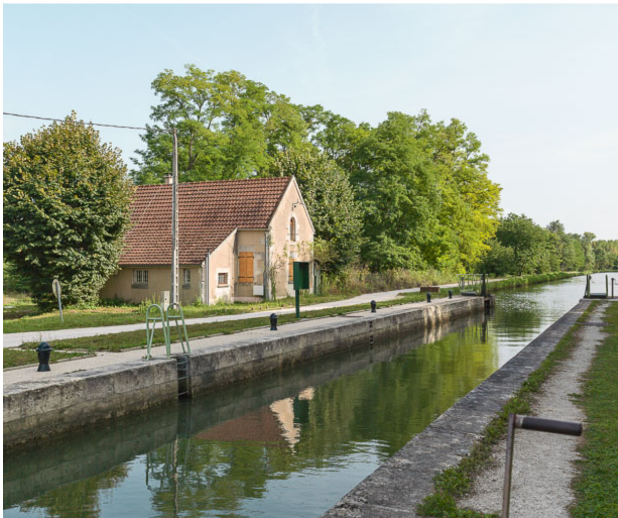
Vue du site d'écluse.
