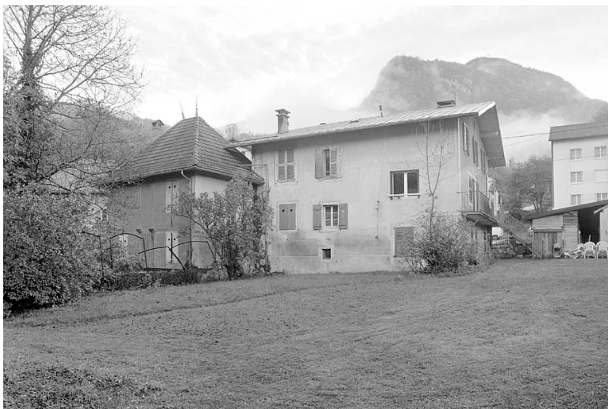
Façade postérieure de l'ensemble.
