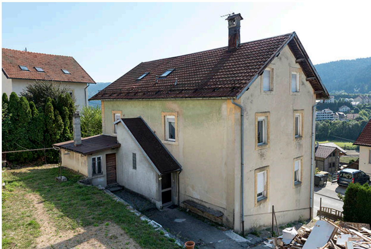
Façades postérieure et latérale gauche.
