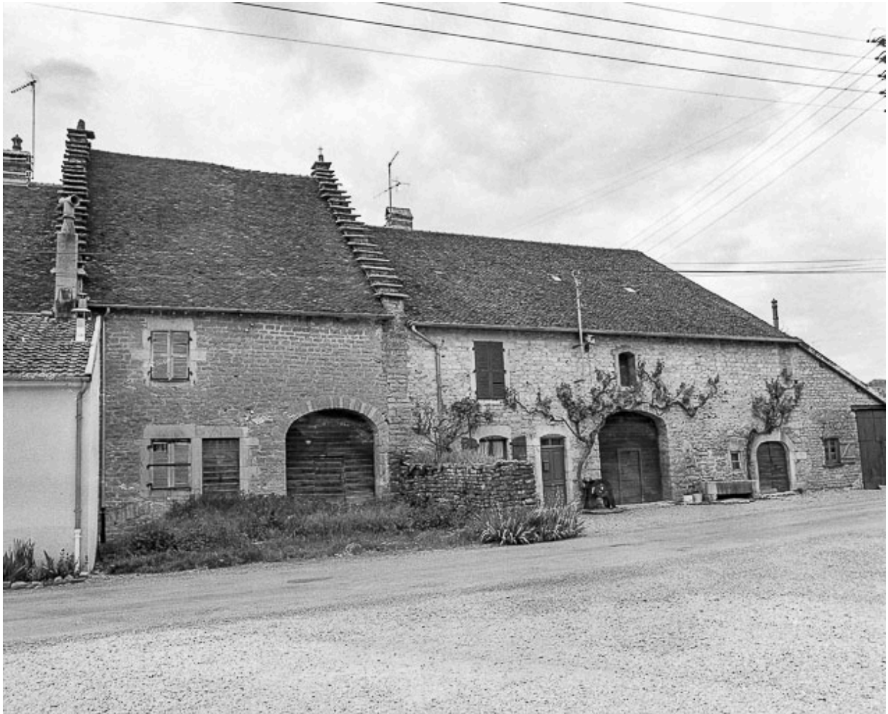
Fermes situées rue Roche : façades antérieures.
