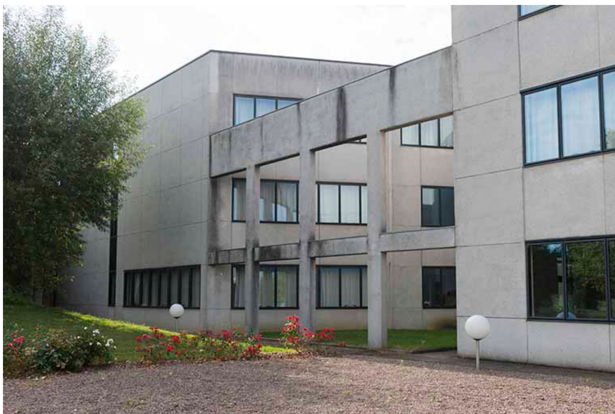
Détail de la façade nord.
