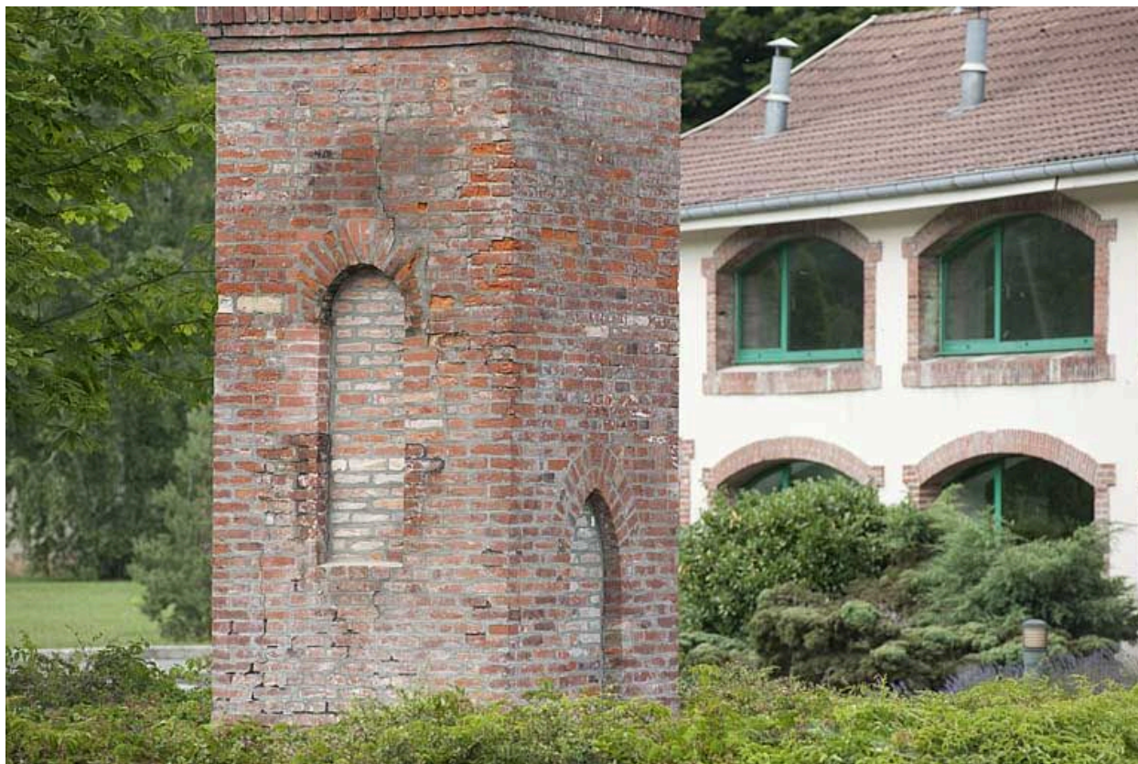
Soubassement de la cheminée carrée.
