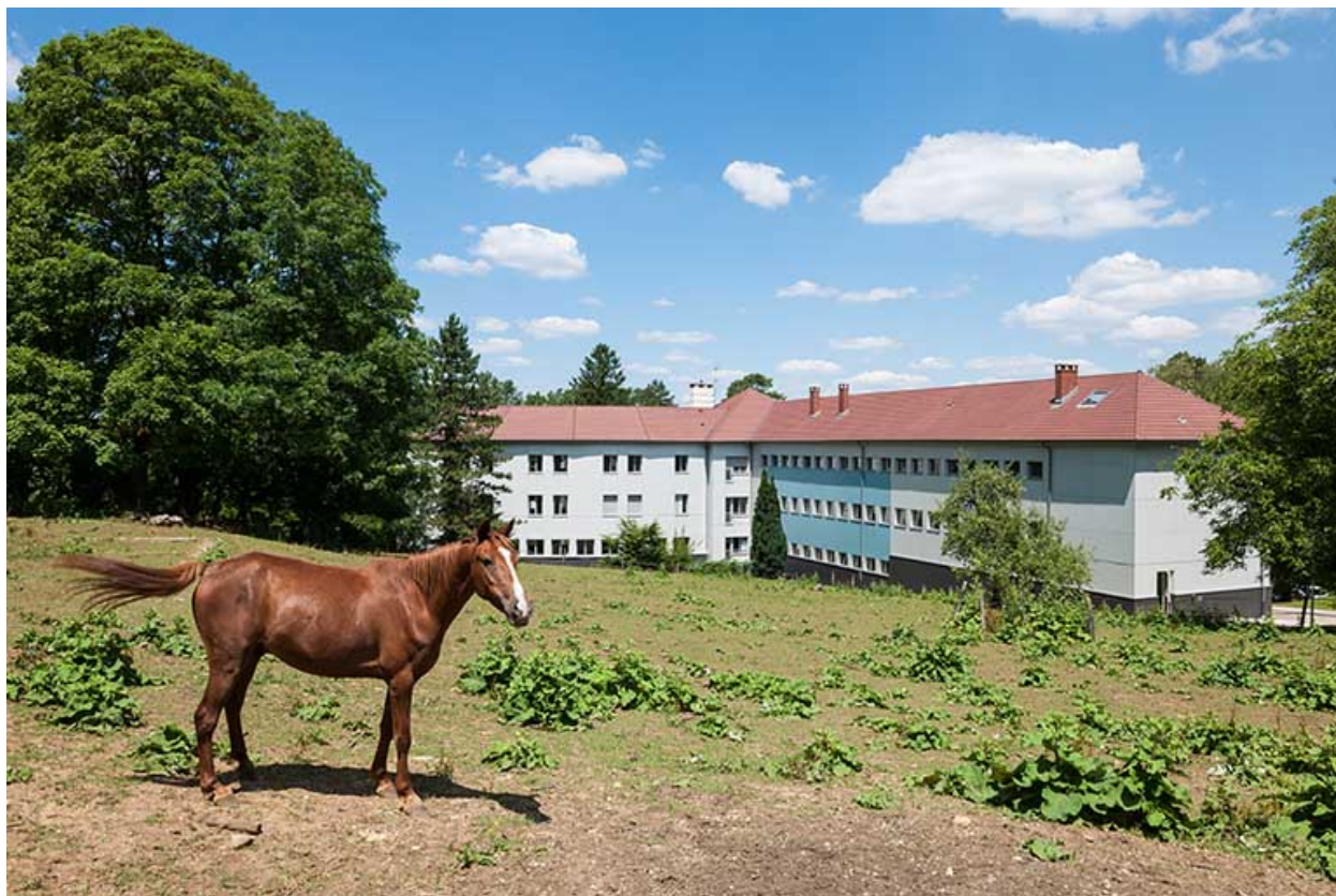
Externat : façade postérieure.
