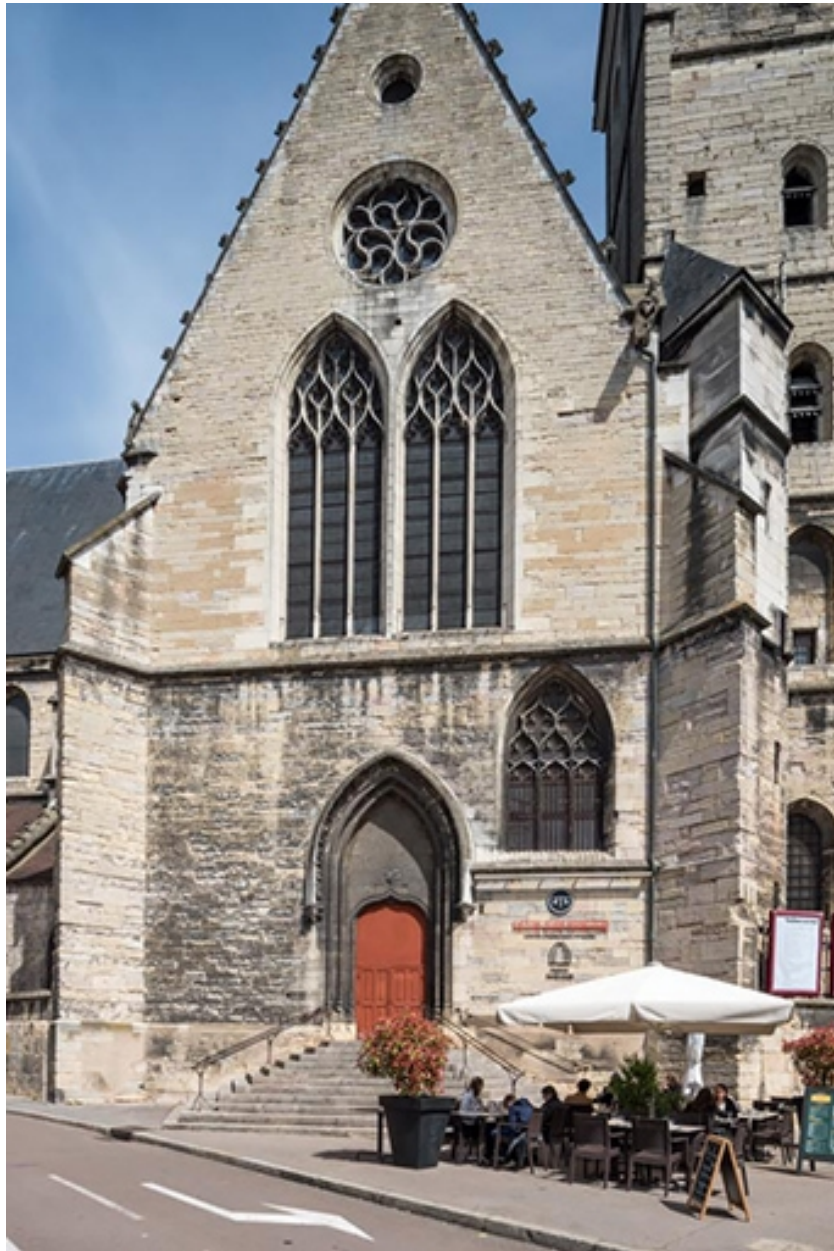
Façade sud : extrémité du transept.
