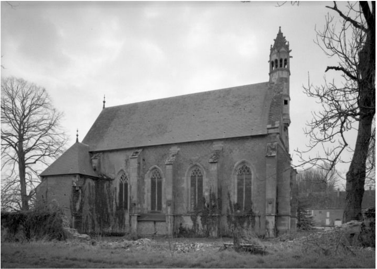
Chapelle de l'ancien château, vue d'ensemble de l'élévation gauche.
