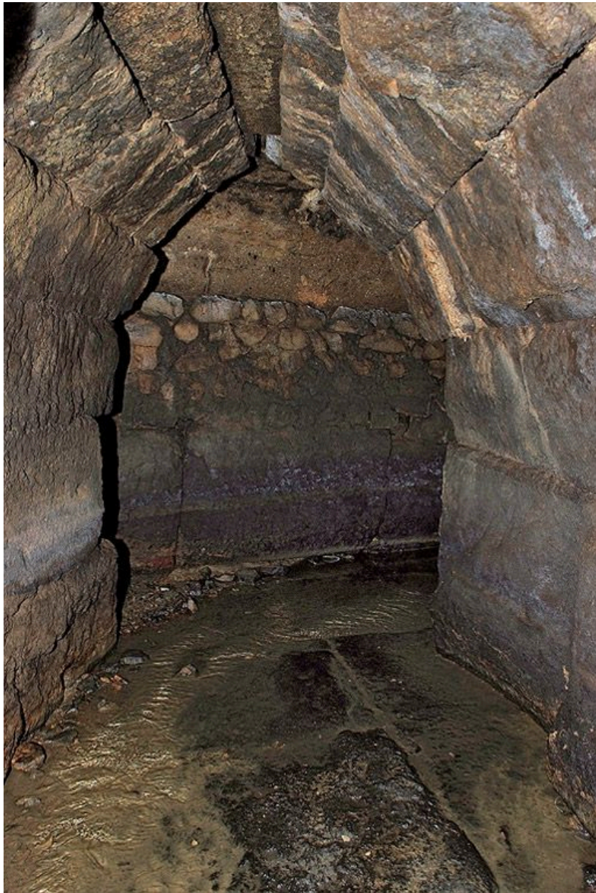
Section reliant les deux galeries.
