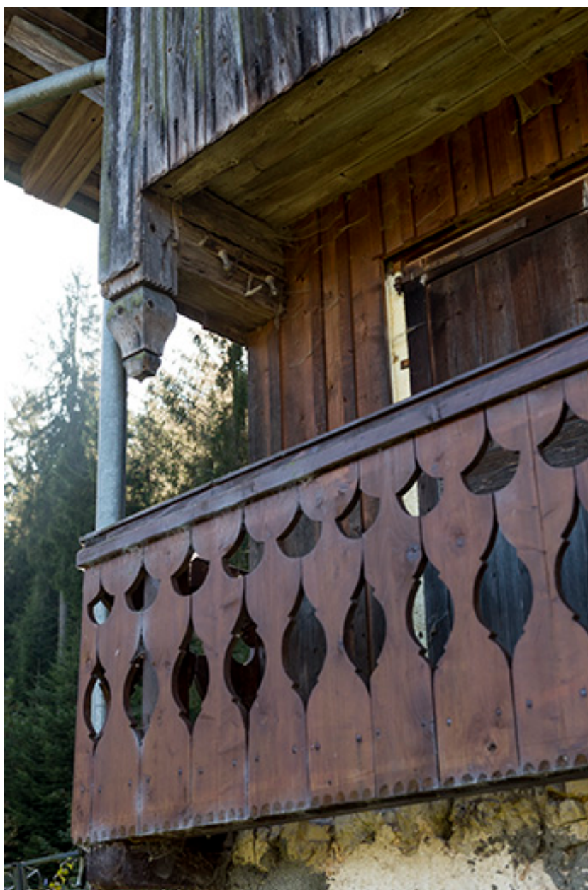
Façade postérieure : détail du garde-corps.
