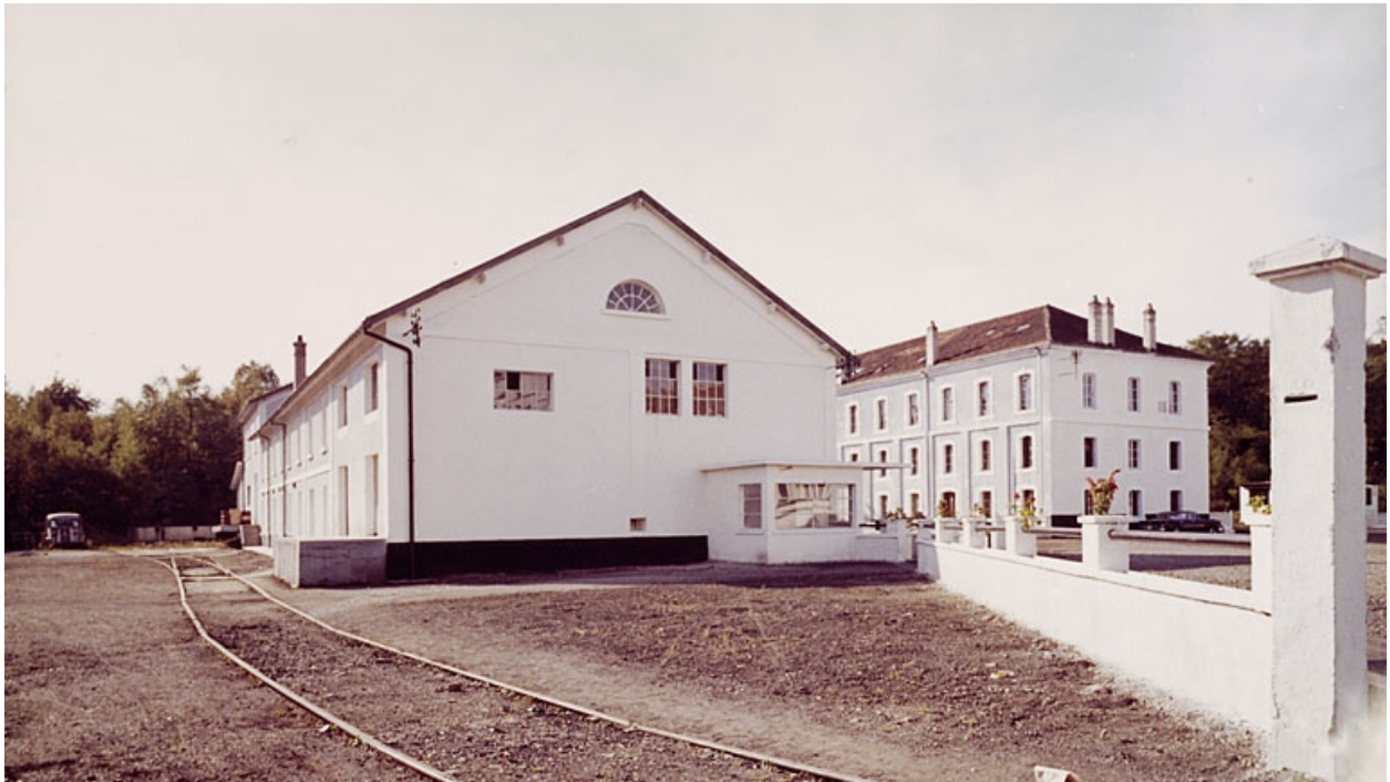
Usine Maglum. Vue d'ensemble depuis l'est.
