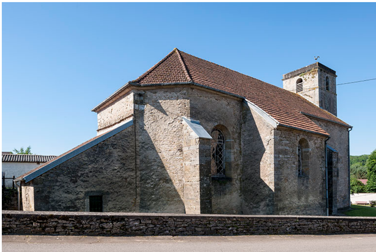
Vue latérale Nord, chevet et sacristie
