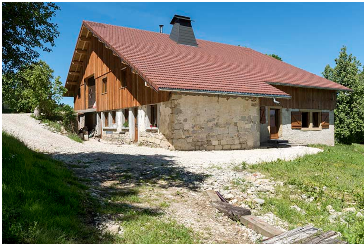
Façades antérieure et latérale droite.
