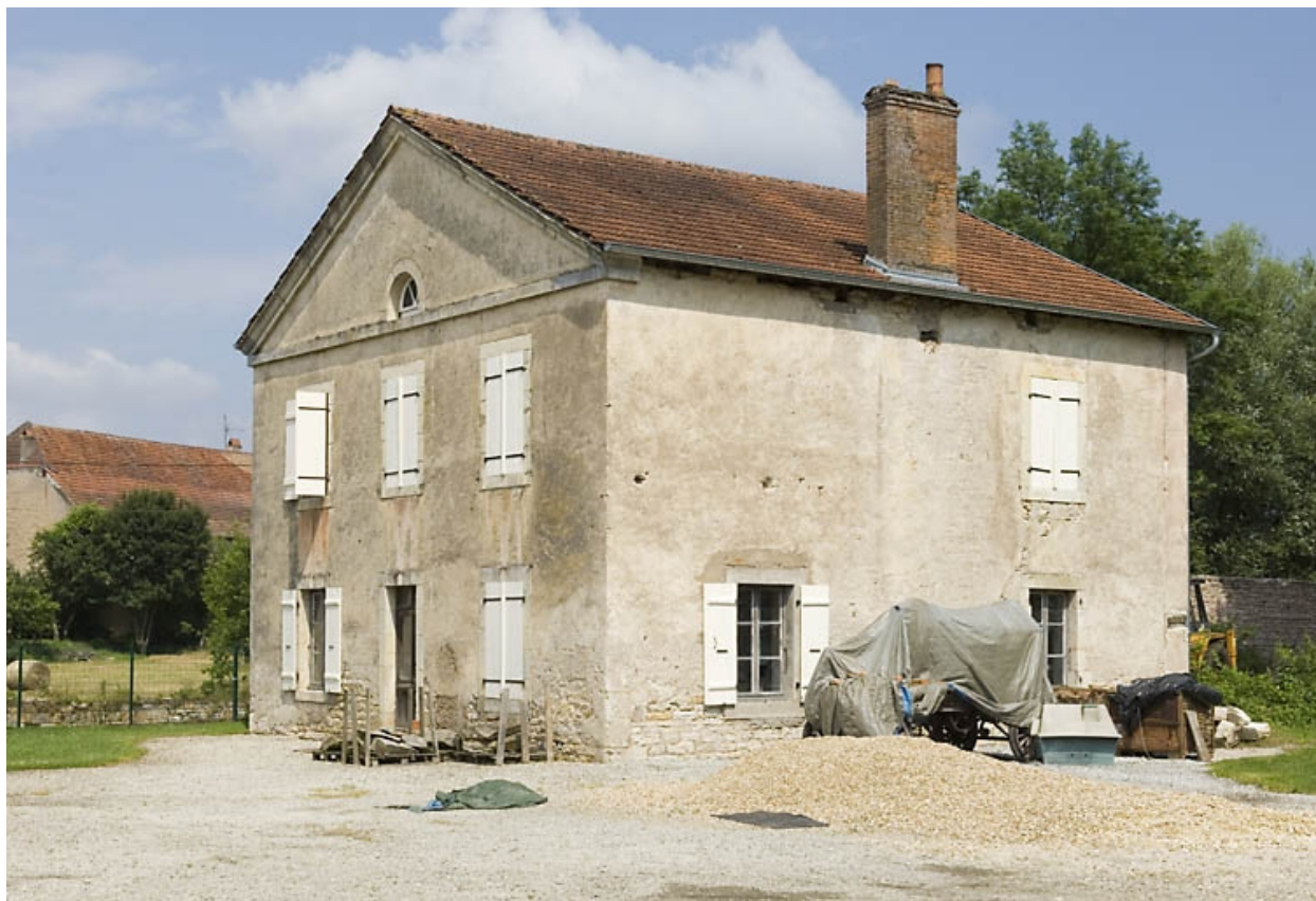
Logement patronal vu de trois quarts.
