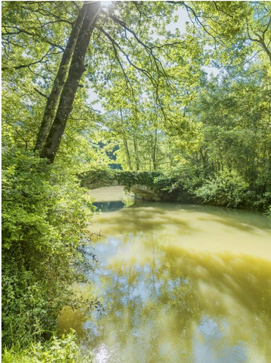
Vue d'ensemble du pont.
