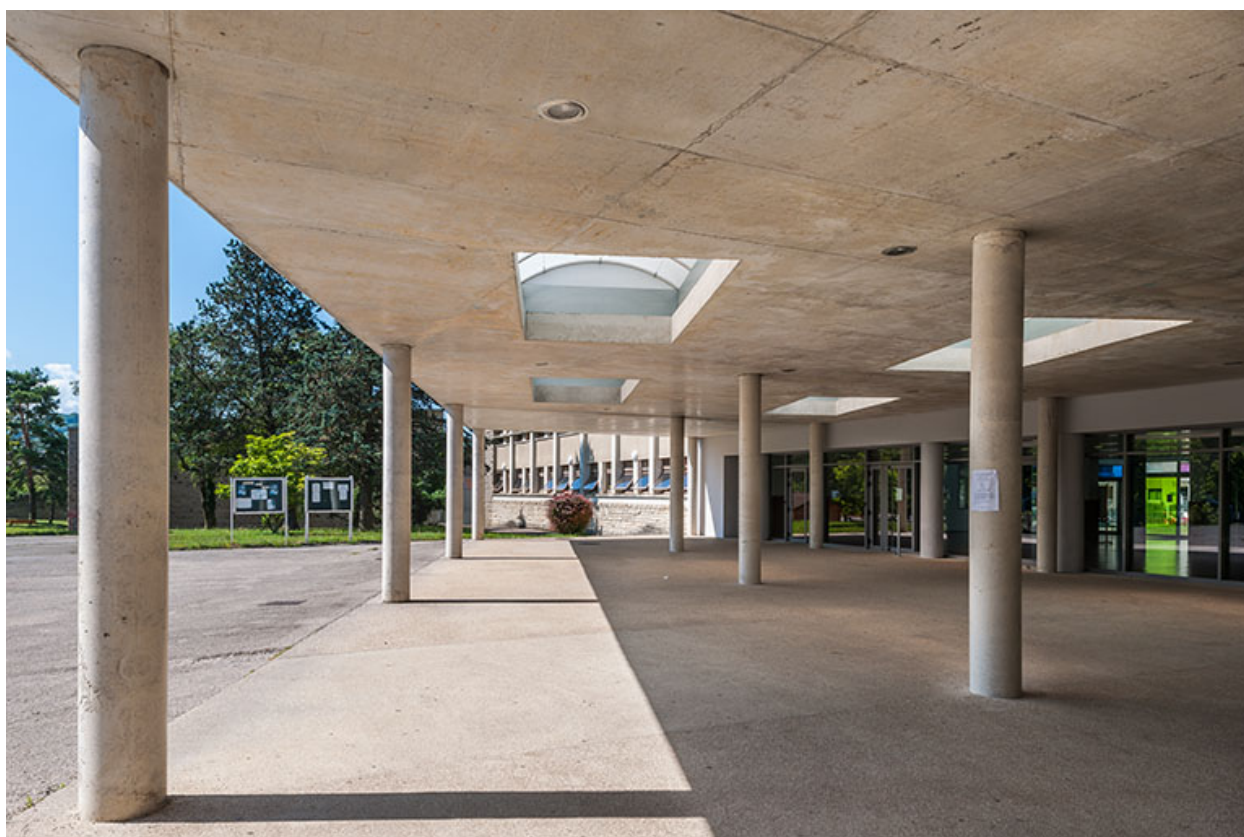
Liaison couverte entre bâtiments et préau.
