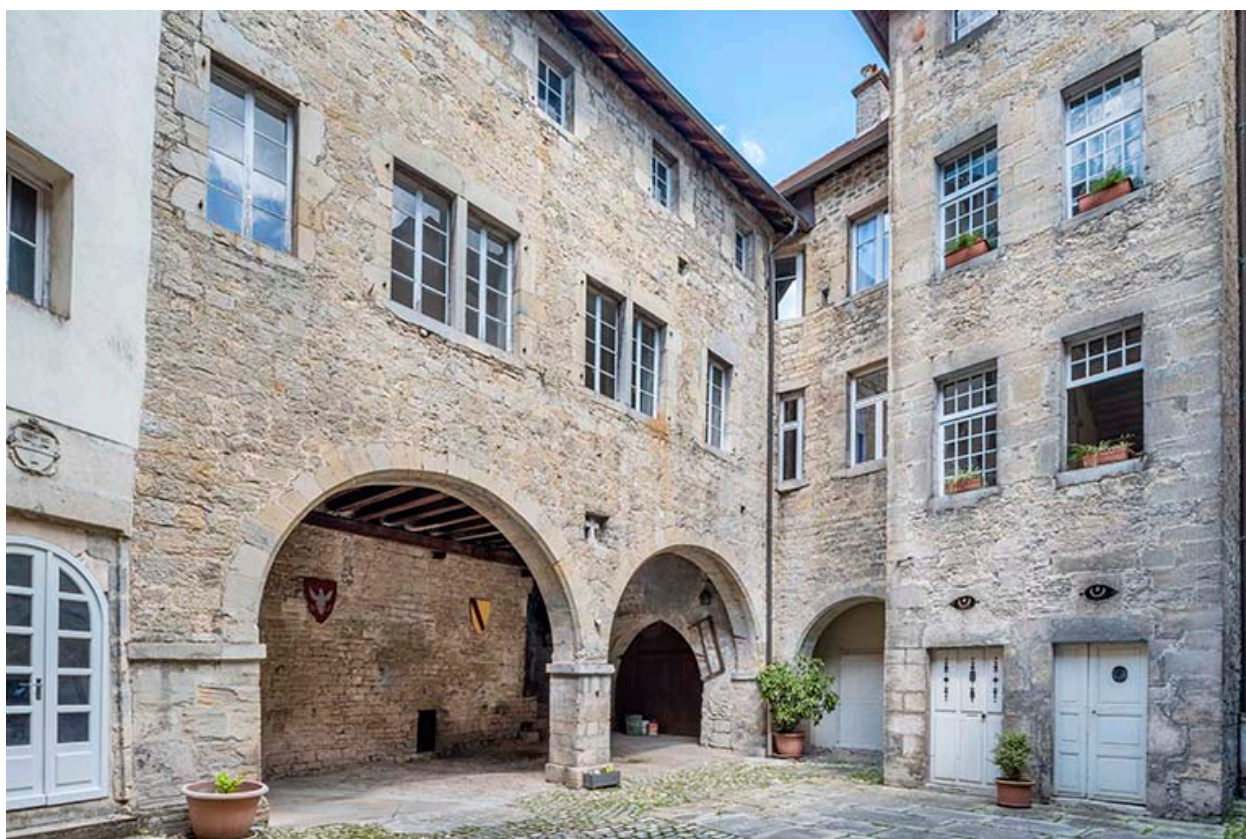
La première cour vue depuis le sud-ouest.
