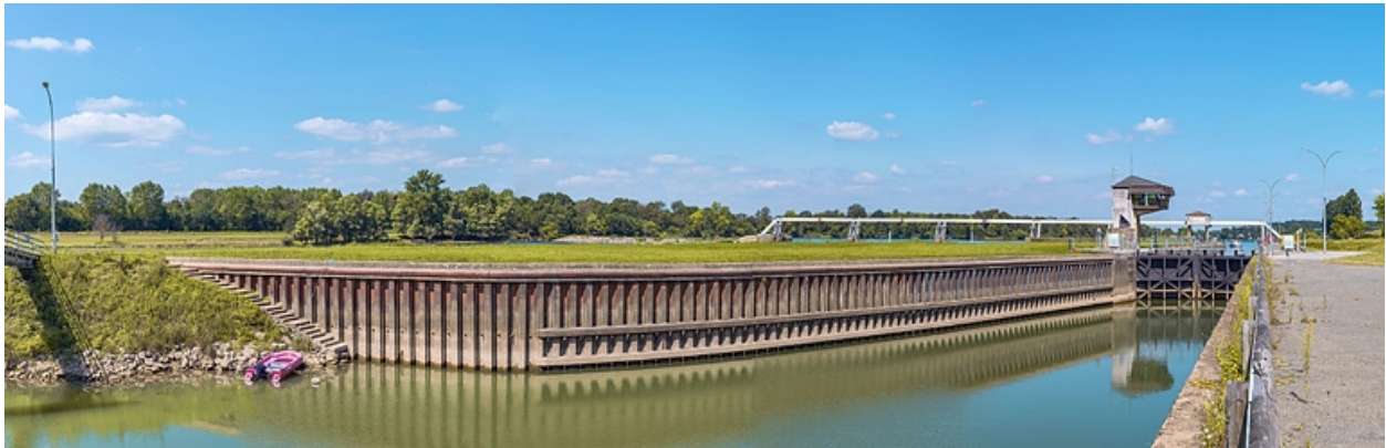
Murs-guides à l'aval du site d'écluse.
