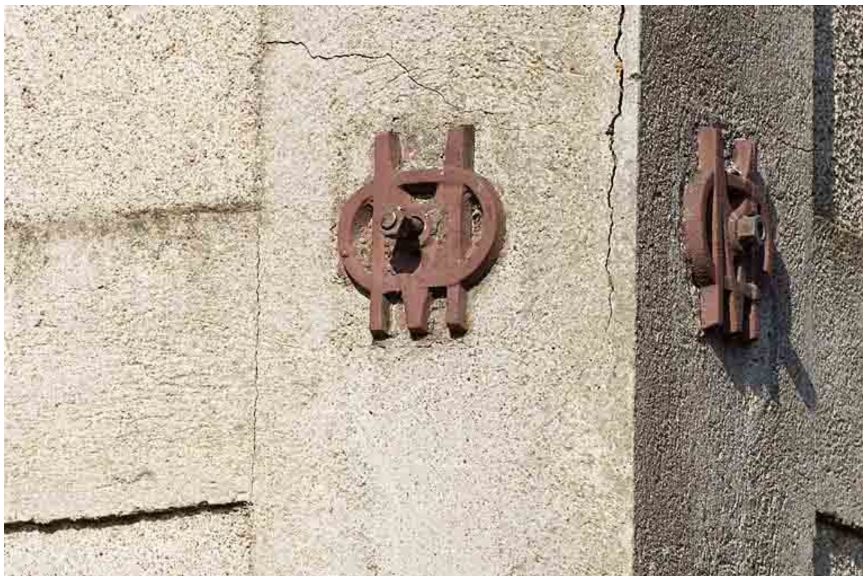
Détail d'une clef de tirant (monogramme des Mines d'Ostricourt).
