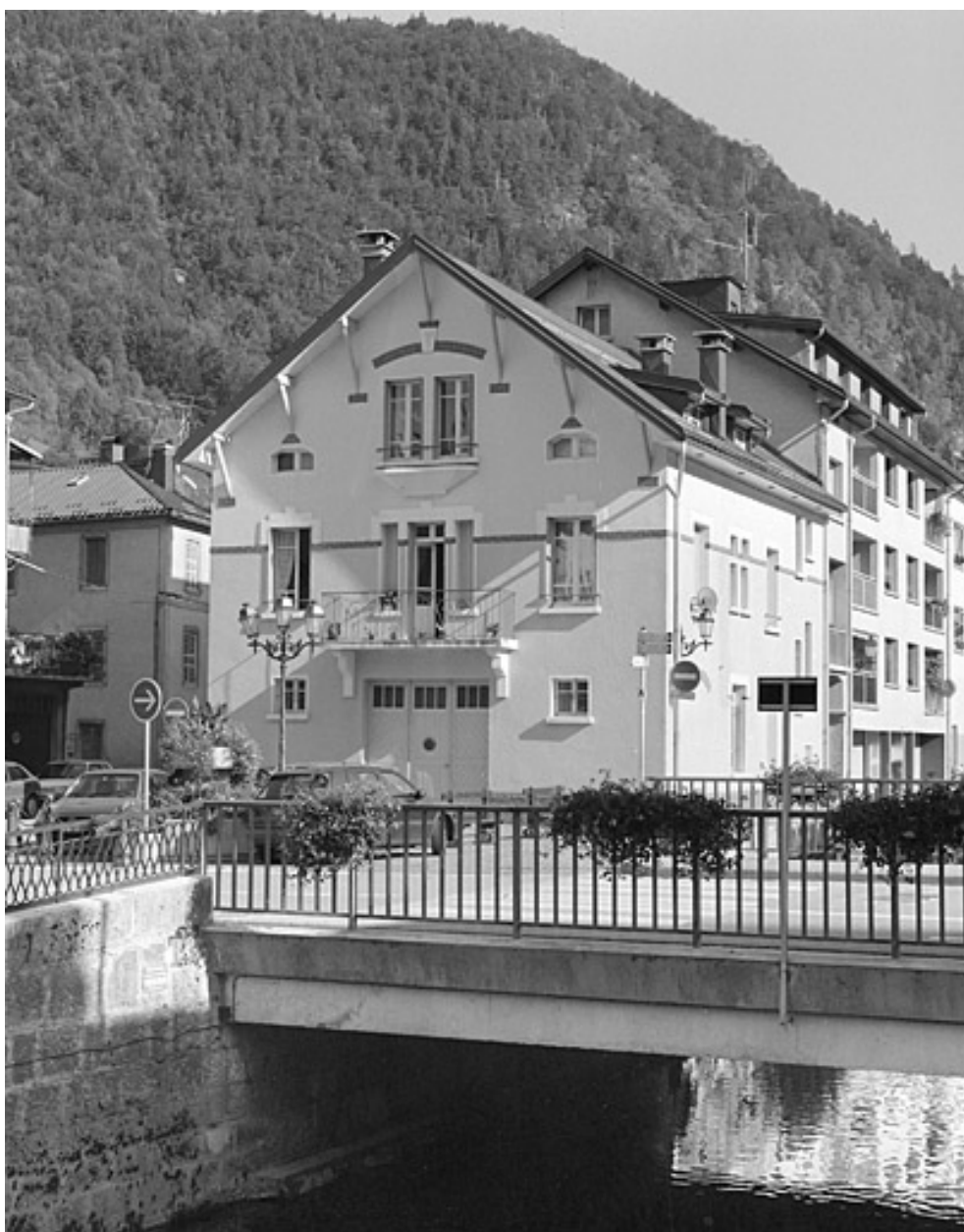
Vue d'ensemble, depuis l'ouest (cadrage vertical).
