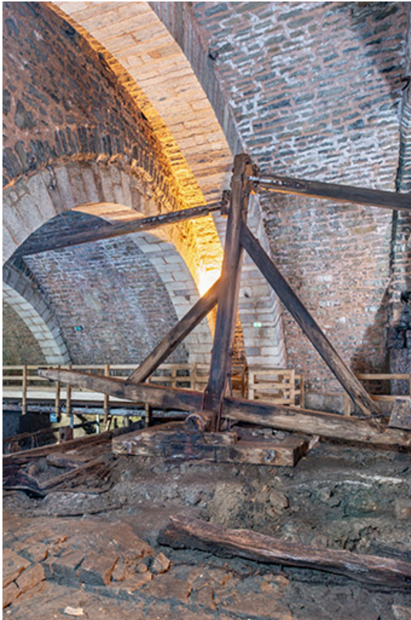
Balancier de la transmission mécanique.
