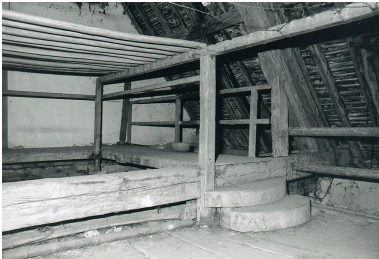
Etage de comble du bâtiment conventuel. Etendoirs (?), 1997.
