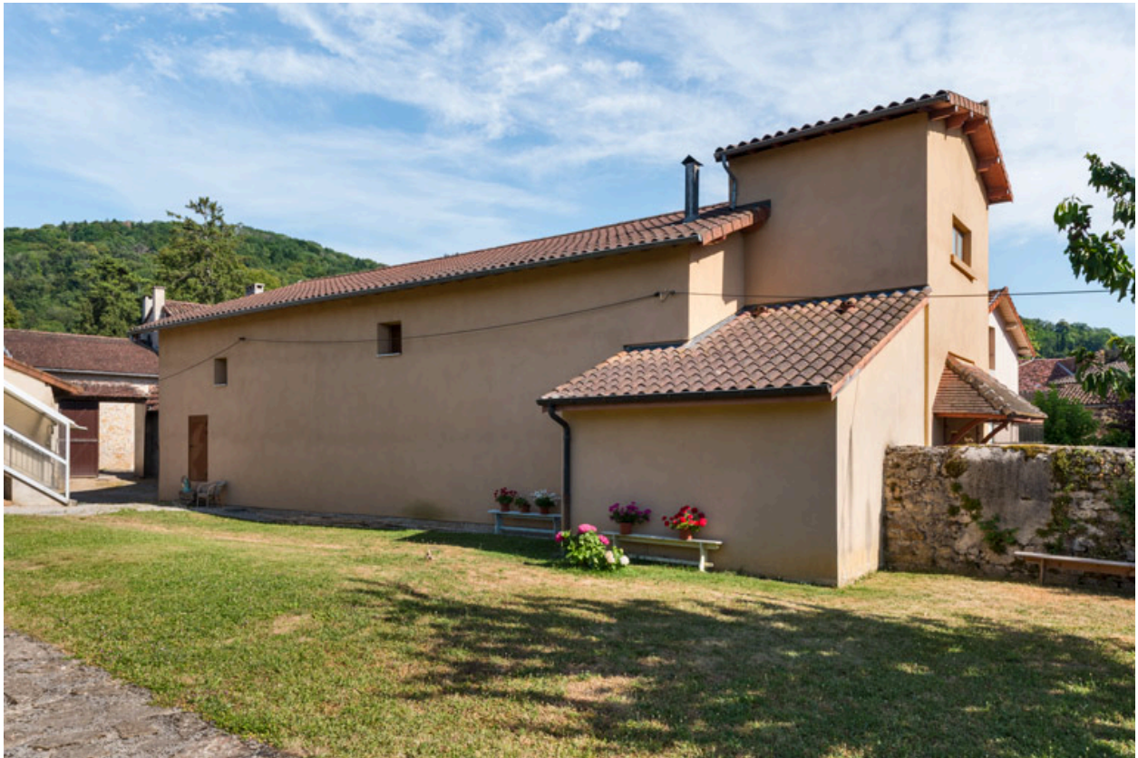
Façade latérale gauche, de trois quarts droite.
