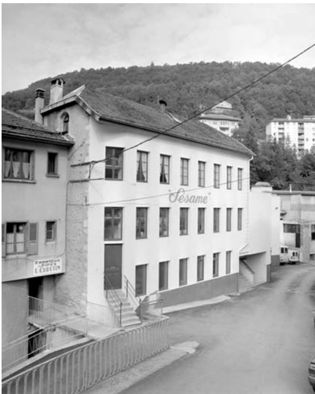
Façade antérieure de l'ancienne usine.
