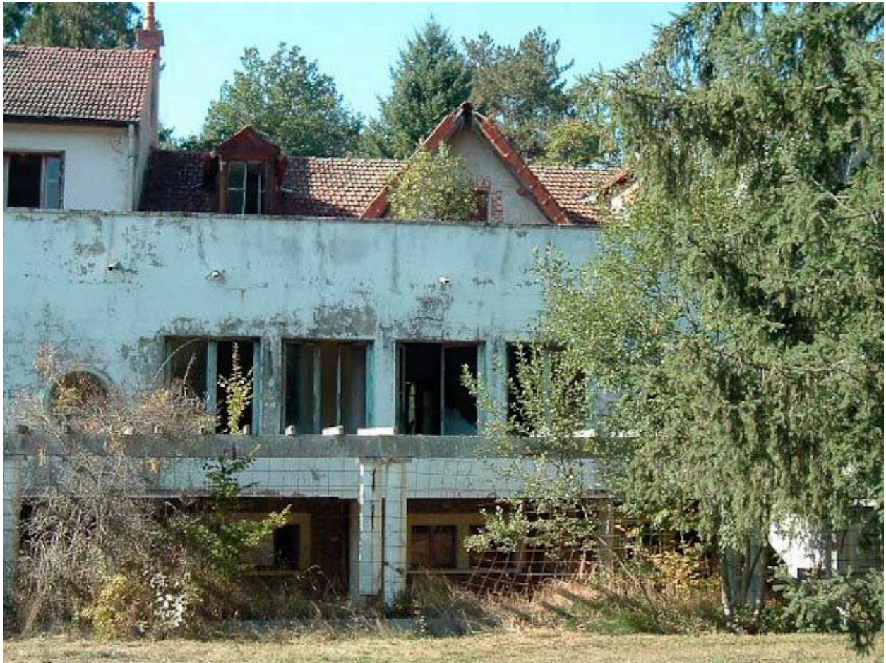
Bâtiment principal, façade antérieure, partie droite.
